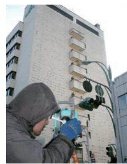
光波測定器による無足場実測 (または足場設置後の実測)
